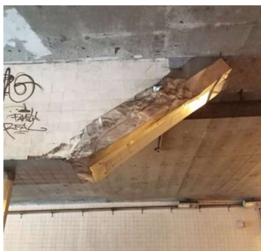
Fig. – chapa de proteção danificada
